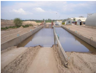
Eine spezielle Beckenkonstruktion sorgt für den korrekten Wasserspiegel in der gesamten Anlage.
