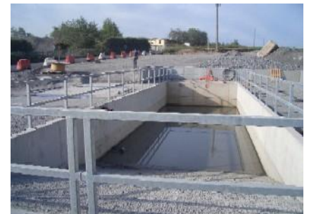
Rampe d'accès pour chargeur sur pneus et garde-corps de sécurité autour du bassin.
