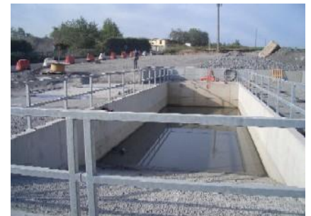
Einfahrtbereich für Radlader mit umlaufendem Geländer geschützt.
