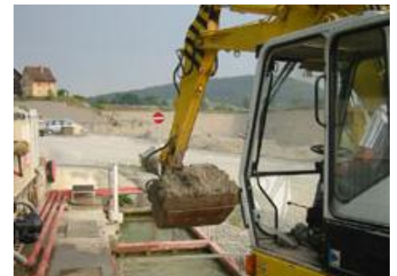
Leeren der Recyclingtanks mit Hydraulikbagger.
