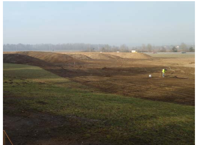
Bild 2: Humusdepot auf der Baustelle
