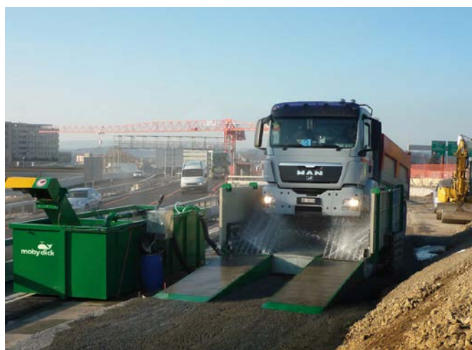
Bild 1s: MobyDick ConLine Mobile auf der Autobahnbrücke Objekt T2
